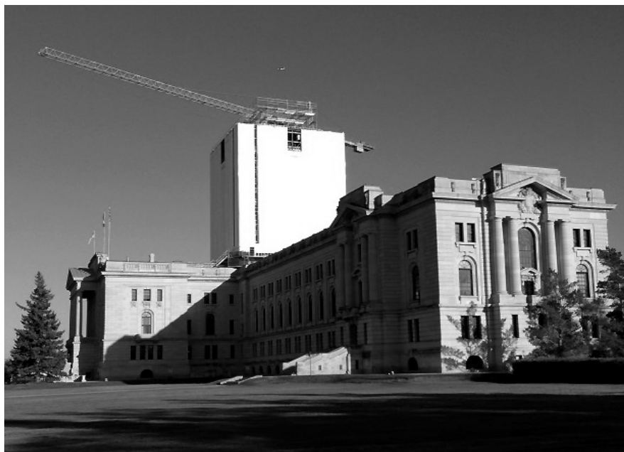
Le dôme du Palais législatif de la Saskatchewan fait actuellement l'objet d'importants travaux de réfection.
